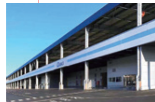
清水(静岡)物流倉庫
