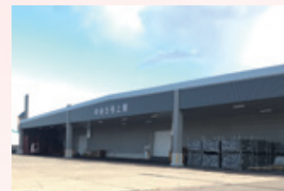
小樽(北海道)物流倉庫
